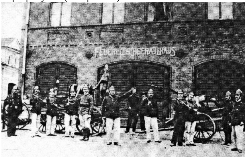
Požární sbor před zbrojnicí se svou výzbrojí (ruční stříkačky)
